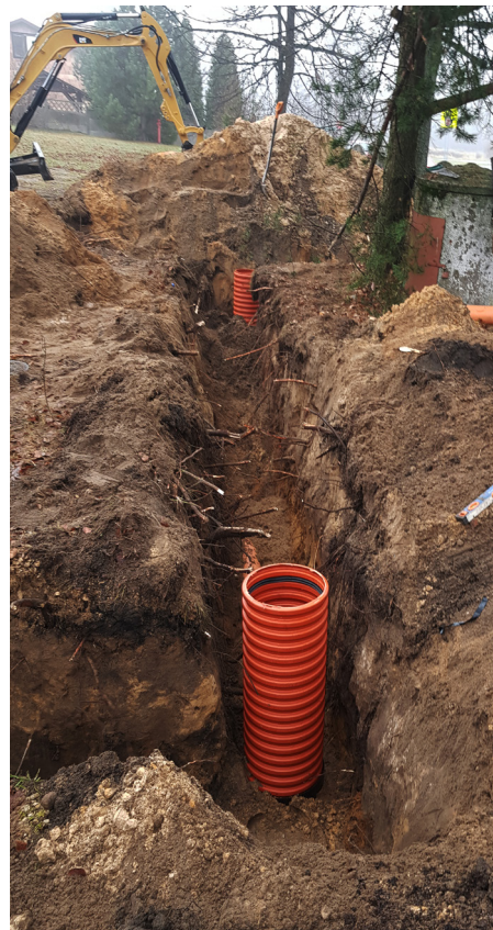
Budowa przyłączy kanalizacyjnych w Gminie Mierzęcice
