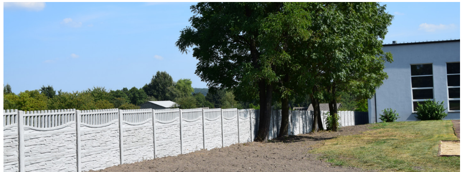
Zakup i montaż ogrodzenia przy Szkole Podstawowej im. M. Konopnickiej w Przeczycach
