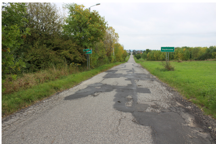
Nowa Wieś ul. Akacyjowa - przed
