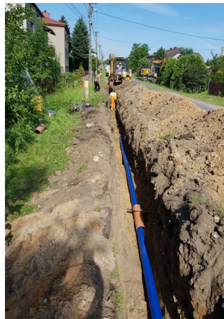
Modernizacja sieci wodociągowej - Przeczycy ul. Targowa
