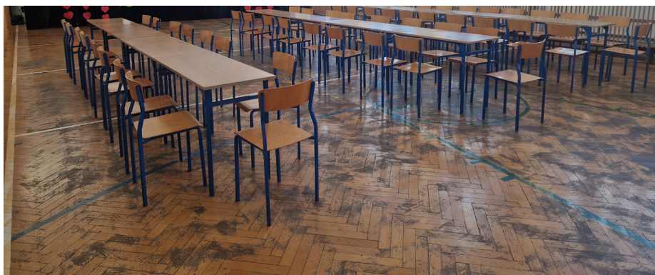
Podłoga na sali gimnastycznej w Przedszkolu Publicznym w Nowej Wsi - przed
