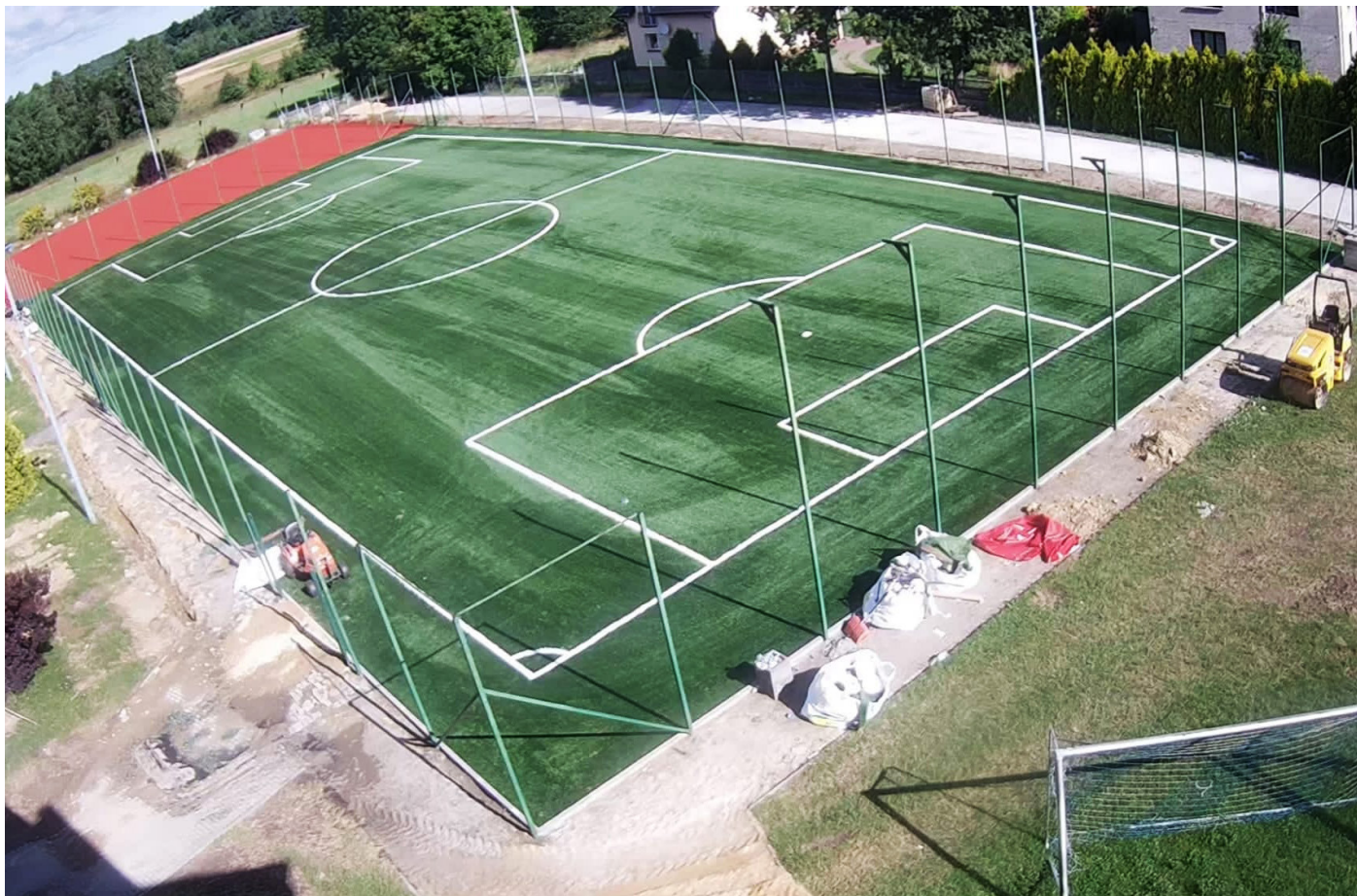
Orlik w Mierzęcicach - w trakcie prac budowlanych
