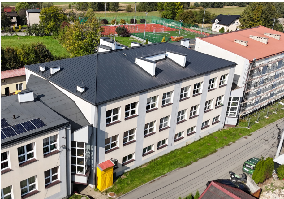
Pokrycie dachowe na budynku SP nr 1 w Mierzęcicach - w trakcie prac
