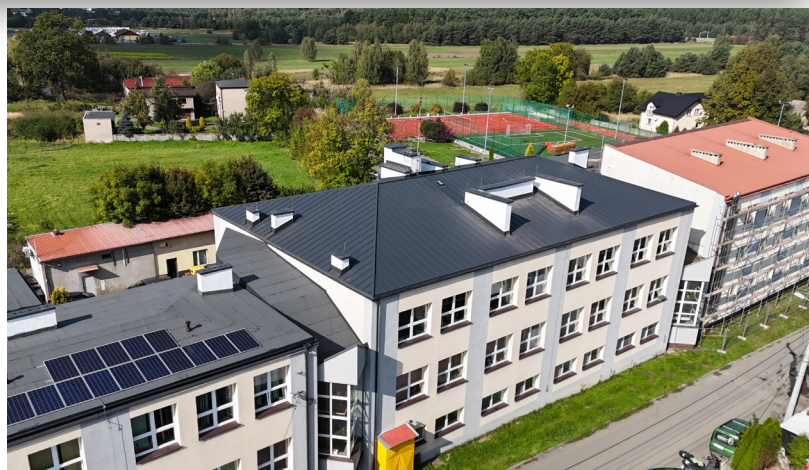
Pokrycie dachowe na budynku SP nr 1 w Mierzęcicach - str. 3
