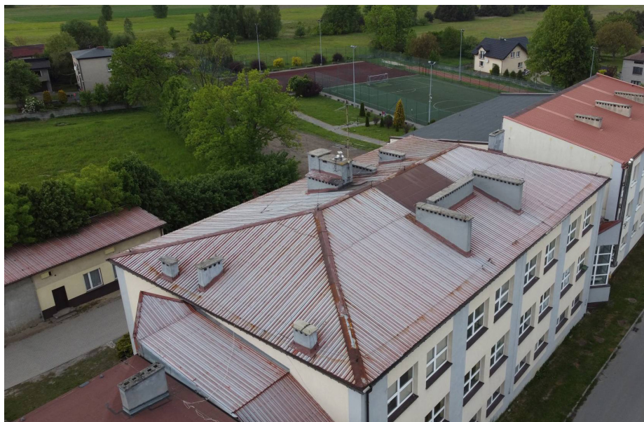
Pokrycie dachowe na budynku SP nr 1 w Mierzęcicach - przed
