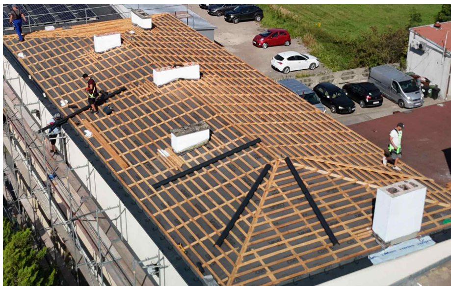
Pokrycie dachowe na budynku SP nr 1 w Mierzęcicach - w trakcie prac
