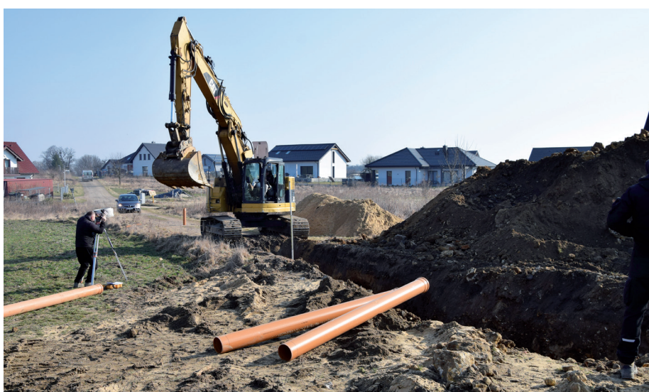
Budowa sieci kanalizacyjnej w Toporowicach
