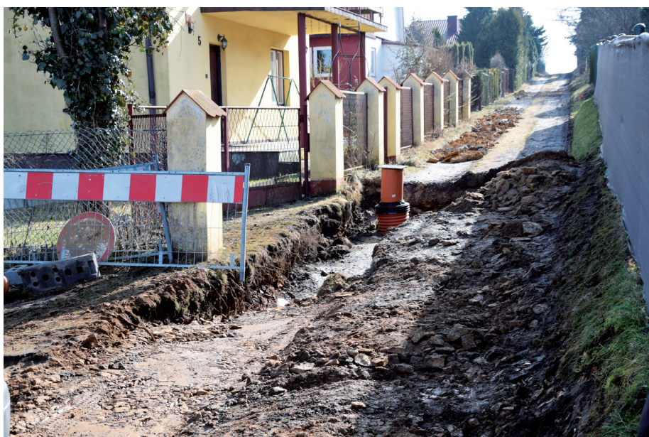
Budowa sieci kanalizacyjnej w Boguchwałowicach
